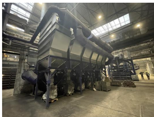
F3, odprašení velkého vytloukacího roštu. F4, F5, odprašení regenerace formovacích směsí.
