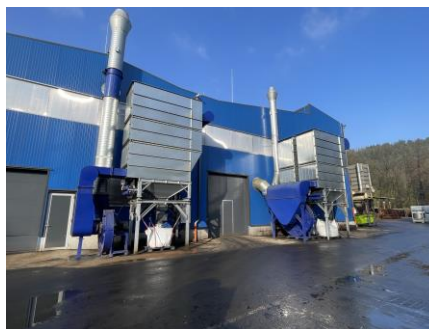
Železářny Štěpánov, realizace r. 2023-2024
