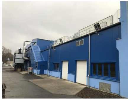
Metalurgie Rumburk, realizace r. 2017 - 2020
