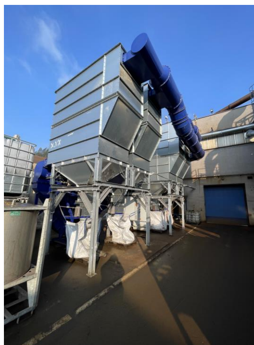
F4.1, F4.2, odprášení čistírny
