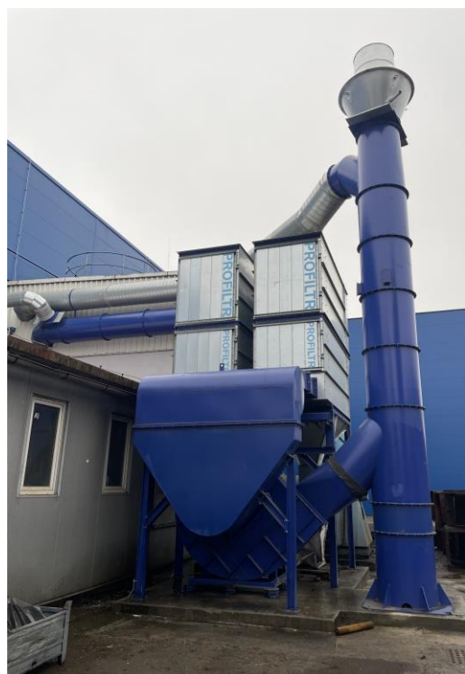
F2, odprášení malého vytloukacího roštu.
