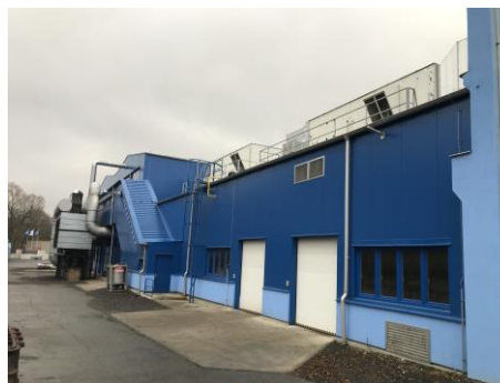
Metalurgie Rumburk, realizace r. 2017 - 2020
