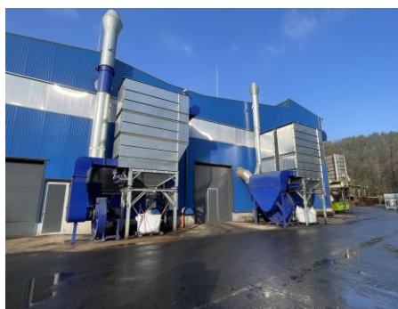
Železářny Štěpánov, realizace r. 2023-2024
