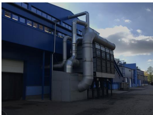
Podtlakové centrální čištění – vysavač, speciální filtrační zařízení
