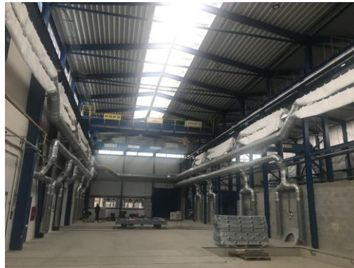
Zákryt vytloukacího roštu a potrubní rozvody
