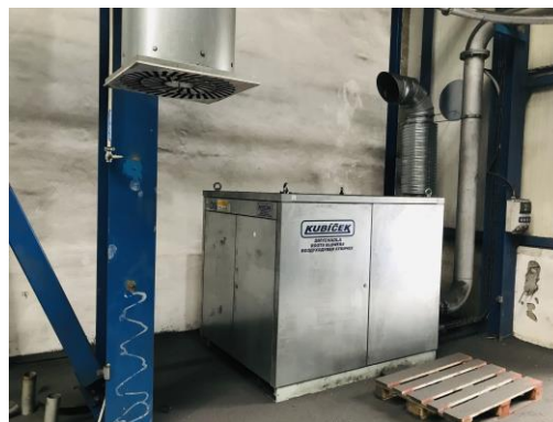
Podtlakové centrální čištění – vysavač, sací agregát, vývěva typu ROOTS
