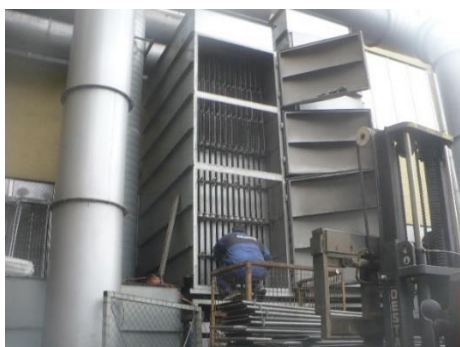
Dodávka a výměna plochých filtračních elementů i pro konkurenční zařízení.
